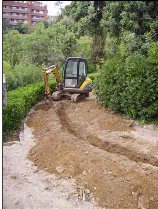
Foto 10. Màquina realitzant la rasa per posar els nous serveis
