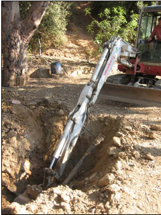
Foto 1. Màquina realitzant el sondeig número 1.
